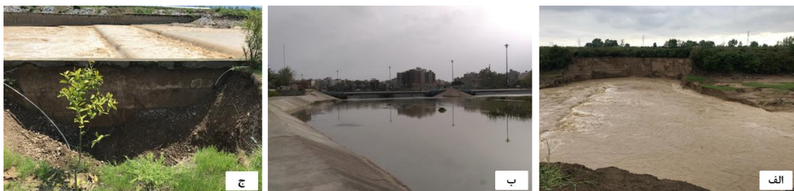
شکل ۵- الف) سیلابدشت و وقوع فرسایش عرضی در مقطع کنترل ۶، ب) سد لاستیکی و پوشش کناره جریان در مقطع کنترل ۴ و ج) سازه کف‌بند در مقطع کنترل ۷ (عکس: نیایش فندرסקی، ۱۳۹۸)
