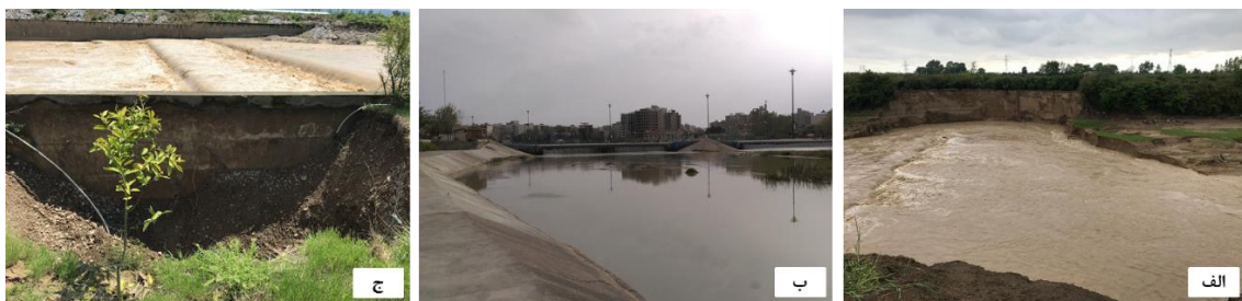
شکل ۵- الف) سیلابدشت و وقوع فرسایش عرضی در مقطع کنترل ۶، ب) سد لاستیکی و پوشش کناره جریان در مقطع کنترل ۴ و ج) سازه کف‌بند در مقطع کنترل ۷ (عکس: نیایش فندرسکی، ۱۳۹۸)
