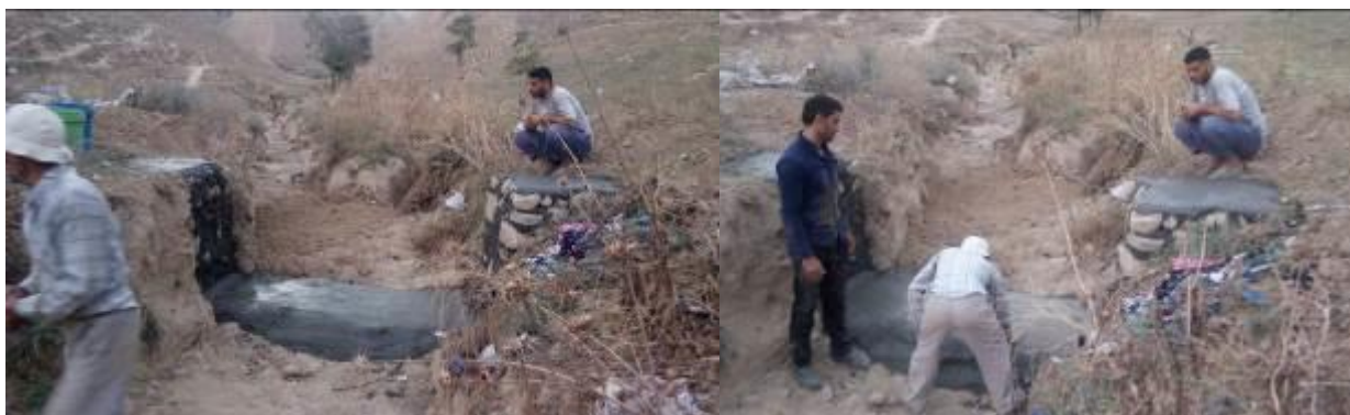
شکل ۳- سطح مقطع با شکل هندسی منظم ساخته شده در خروجی منطقه مورد مطالعه Figure 3. Regular geometrically shaped cross-section made at the exit of the studied area
