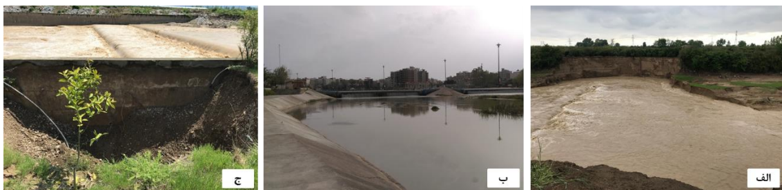
شکل ۵- الف) سیلابدشت و وقوع فرسایش عرضی در مقطع کنترل ۶، ب) سد لاستیکی و پوشش کناره جریان در مقطع کنترل ۴ و ج) سازه کف‌بند در مقطع کنترل ۷ (عکس: نیایش فندرסקی، ۱۳۹۸)
