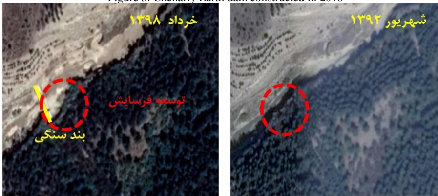
شکل ۶- بند سنگی ملاتی پالچقلی احداث شده در سال ۱۳۹۷ Figure 6. Palechegheli checkdam constructed in 2018
