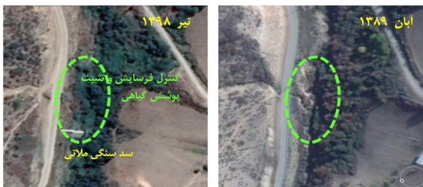
شکل ۳- بند سنگی ملاتی مجاور روستای آلتی آقاج کوچک احداث شده در سال ۱۳۹۳ Figure 3. A masonry checkdam near Altiaghaj koochak village that constructed gain 2014
