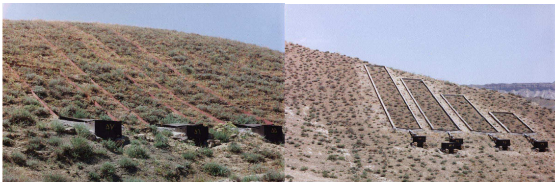
شکل ۲- نمونه‌ای از پلات‌های احداثی سیمانی در خاک کم عمق شکل ۳- نمونه‌ای از پلات‌های احداثی فلزی در خاک عمیق.
