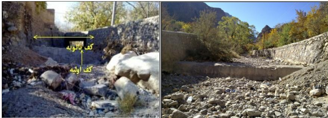
شکل ۲- کاهش عرض و عمق جریان رودخانه منشاد بر اثر ساخت و سازه‌های غلط
