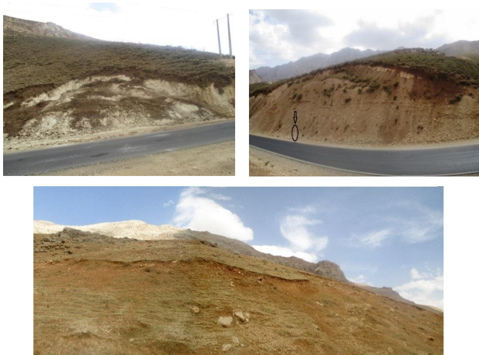
شکل ۱۵- نمونه‌ای از لغزش‌های رخ داده در منطقه Figure 15. An example of landslides occurring in the study area
