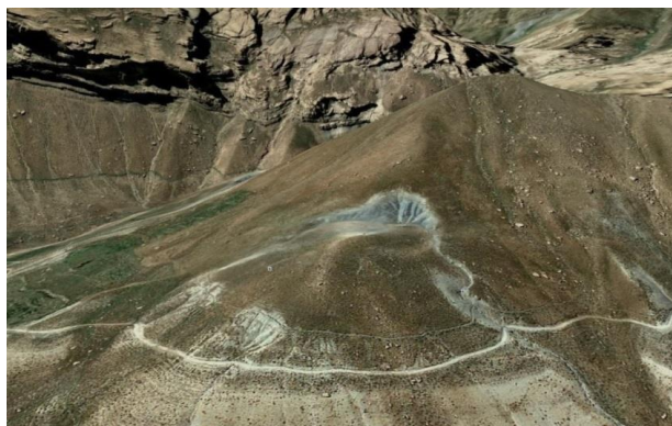
شکل ۶- نمونه‌ای از لغزش‌های منطقه مورد مطالعه Figure 6. A sample of landslides in the study area
