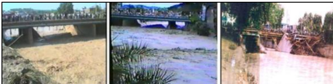
شکل ۶- تصاویر خرابی پل جهت تخمین میزان گرفتگی
