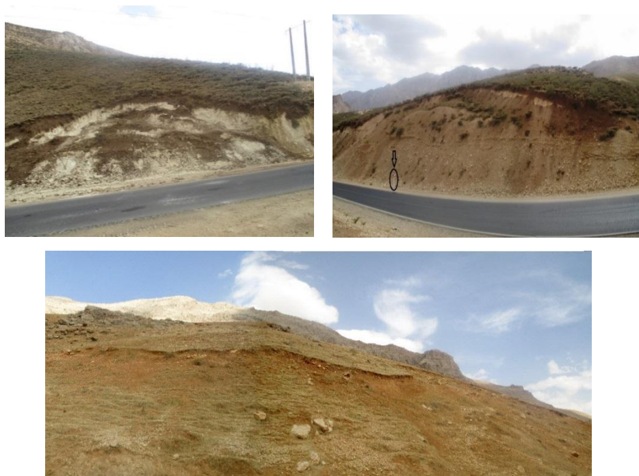
شکل ۱۵- نمونه‌ای از لغزش‌های رخ داده در منطقه Figure 15. An example of landslides occurring in the study area
