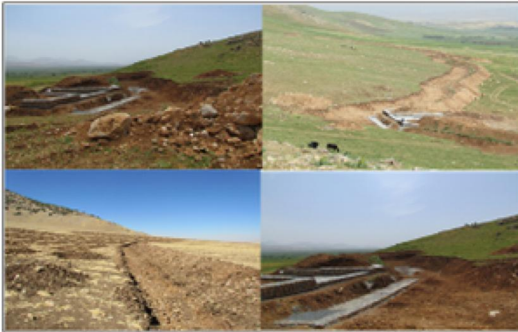
شکل ۳- جایجایی حجم زیاد خاک با بولدوزر حوضه رزین برای ایجاد کانال کنترل سیل. بر اساس مشاهدات میدانی، آثار فرسایش، لغزش، انحلال، رسوبگذاری و سیل در بالادست وجود نداشت و ژئومورفولوژی، پوشش گیاهی و خاکشناسی شرایط لازم برای نفوذ جریانات سطحی فراهم آورده است.
