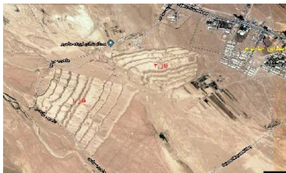
شکل ۱- تصویر ماهواره‌ای شبکه پخش سیلاب جاجرم Figure 1. Satellite image of the Jajarm plain floodwater spreading systems
